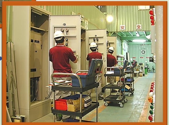
製造電裝配線
